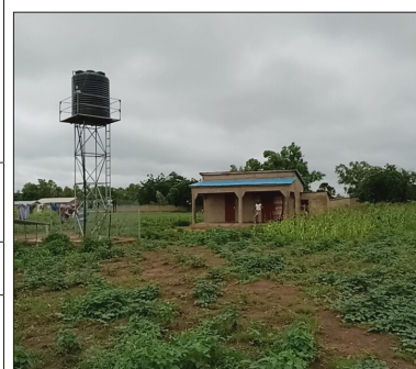
local de transformation
