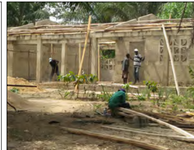
Construction d'un des premiers bâtiment de l'école MEA
