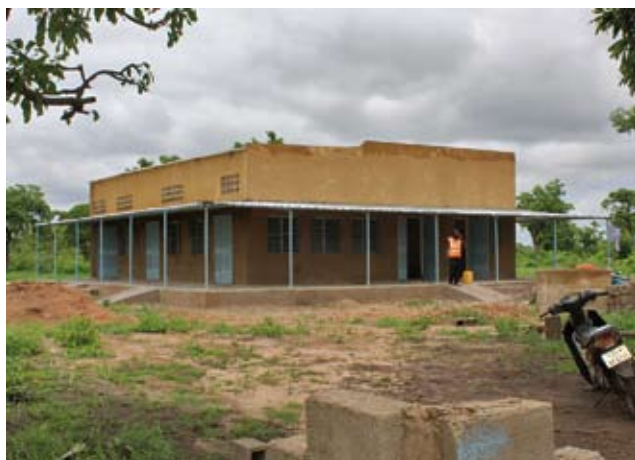
Le bâtiment principal du centre est construit
